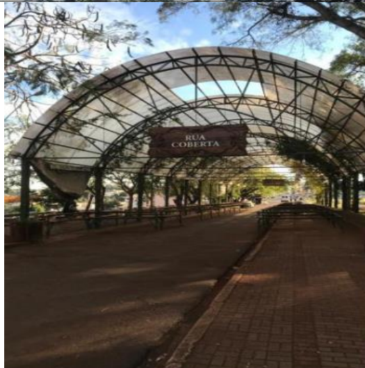
FOTO 8 - Vista da Rua Coberta
