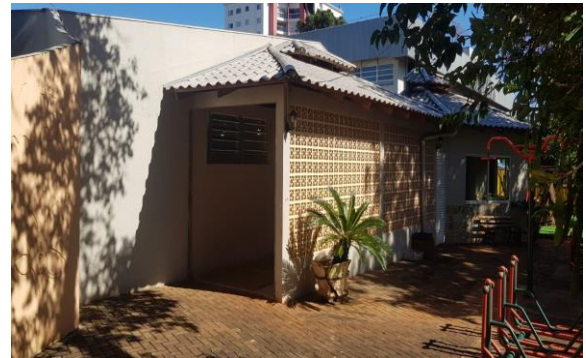
FOTO 16 - Acesso aos banheiros
