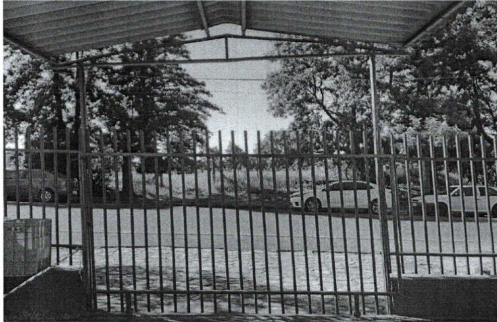
Portão Escola Municipal Tancredo Neves (portão de correr com fechamento na lateral esquerda da foto)
