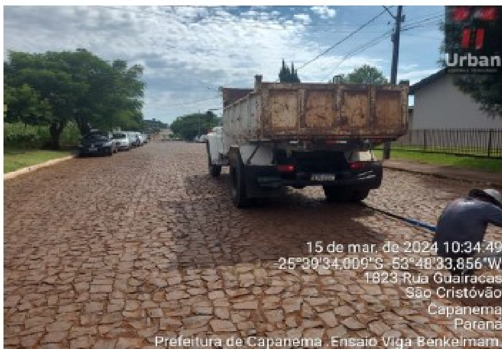
Figura 2 – Ensaio na Rua Guaracás
