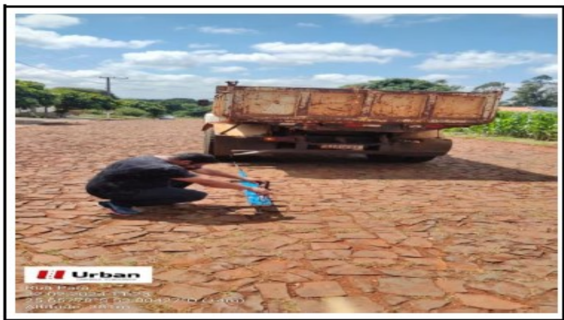
Figura 2 – Ensaio na Rua Pará
