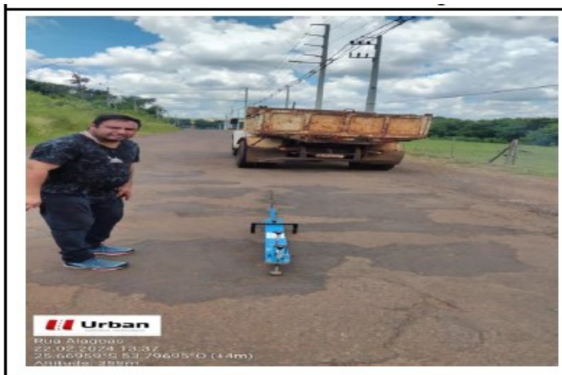
Figura 2 – Ensaio na Rua Alagoas
